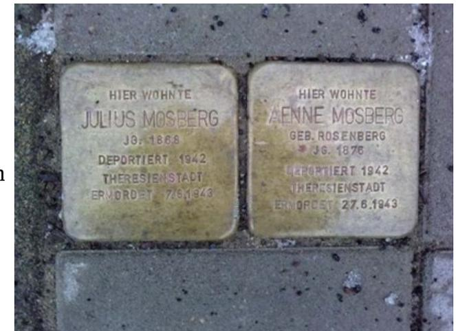
Die Betonwürfel sind 10x10x10 cm, in sie ist eine Messingplatte eingelassen, welche an der Oberfläche zu sehen ist, die Messingplatte ist vergoldet.
